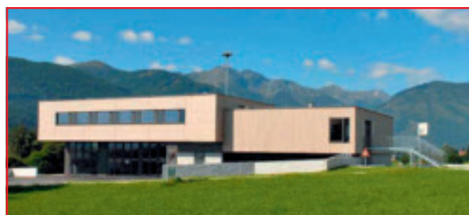
Unsere neue Dienststelle in St. Michael/St. Martin
