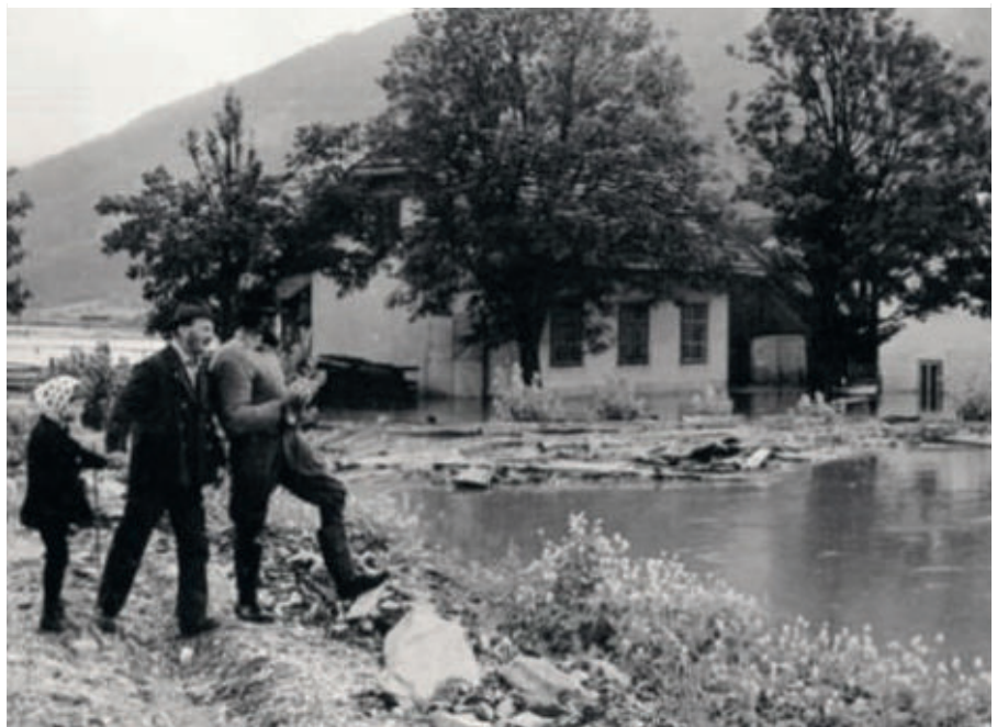
Die vom Hochwasser im August 1966 schwer betroffenen Häuser auf der Au.
