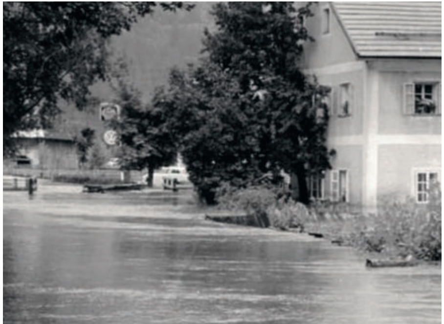
Die Au stand unter Wasser. Im Bild die Kreuzung vor Auenschmied/Lechner, wo auch die Straße überflutet war.
